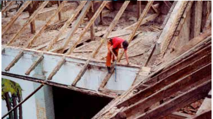
Das Hauptgebäude vor der Renovierung.
